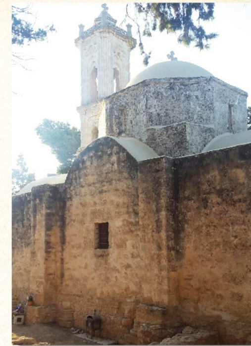
Ο αρχαίος ναός Μεταμορφώσεως του Σωτήρος (12 ος αι.) κτισμένος πάνω στα θεμέλια της Βασιλικής του 4 ου αι., Σωτήρα Αμμοχώστου.
